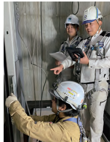
エレベーター設置の点検。
